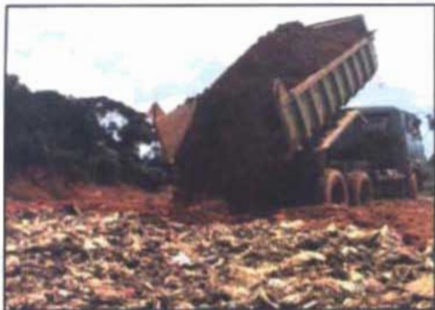
Pelapisan Tanah Penutup Harian dengan Ketebalan Berkisar 15-20 cm
